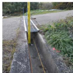
周遊歩道横断部の水路の流下能力不足と上下流の水路が素掘側溝で流下能力の確保が課題
