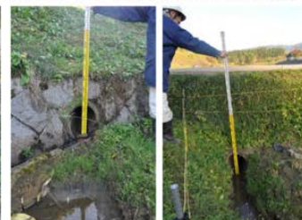
周遊歩道横断部の水路の流下能力不足と上下流の水路が素掘側溝で流下能力の確保が課題
